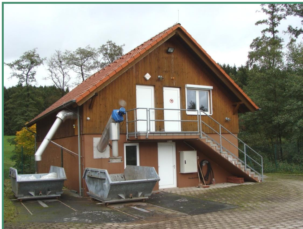
bio-pročistač za 550 ES kompletno smješten u «običnoj» kući
