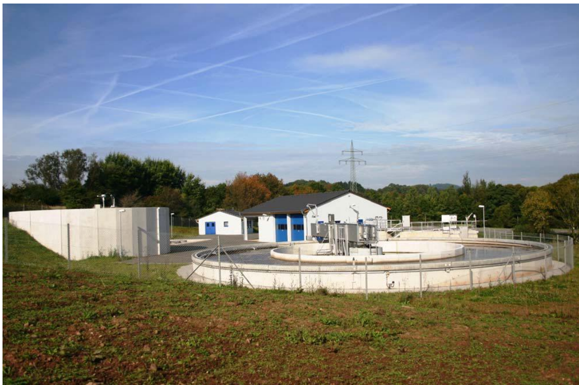
primjer bio-pročistača za 5.500 ekvivalentnih stanovnika
