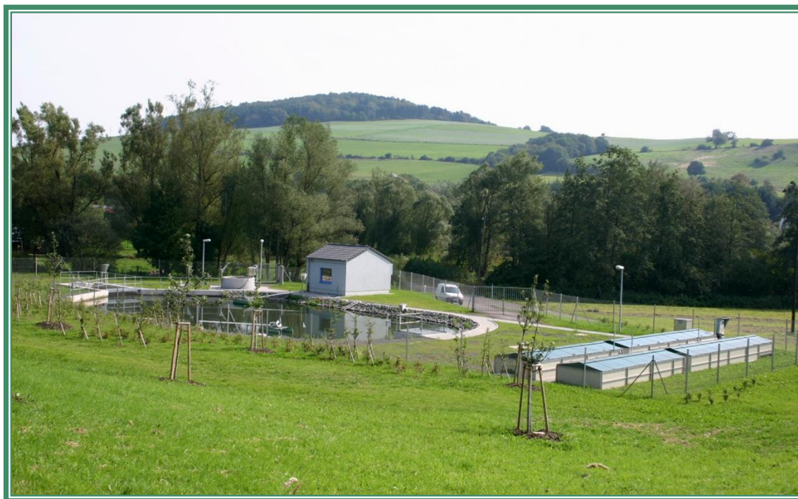
primjer bio-pročistača sa tehnologijom sa biorotorima za 600 ES
